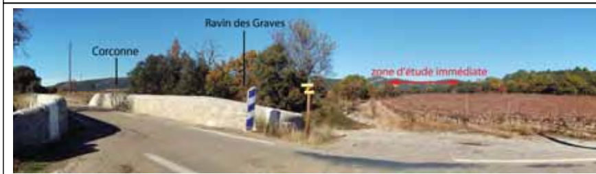
Photo 9 : Le pont de Vère et le sentier du ravin des Graves (d)
