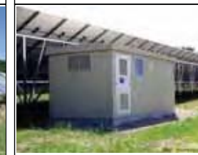
UN POSTE ELECTRIQUE DE TRANSFORMATION
